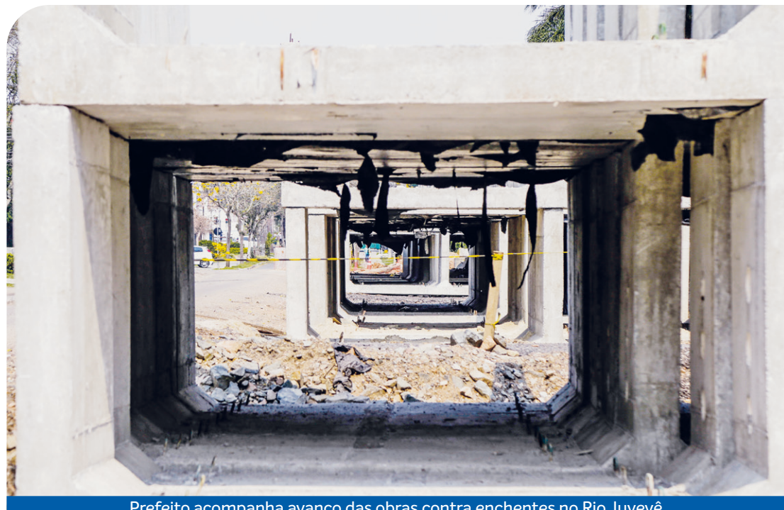
Prefeito acompanha avanço das obras contra enchentes no Rio Juvevê.
